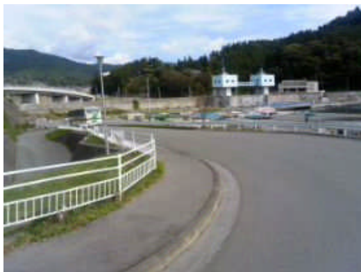
《今日の作業現場 津波はこの防波堤を越えていました》
