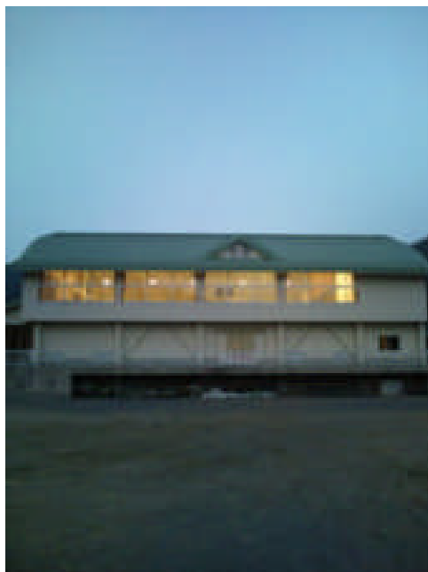
《体育館の外観》
