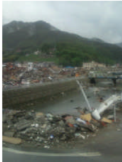
《大船渡市の被災状況。中心街では、より多くの瓦礫が山積していました》
